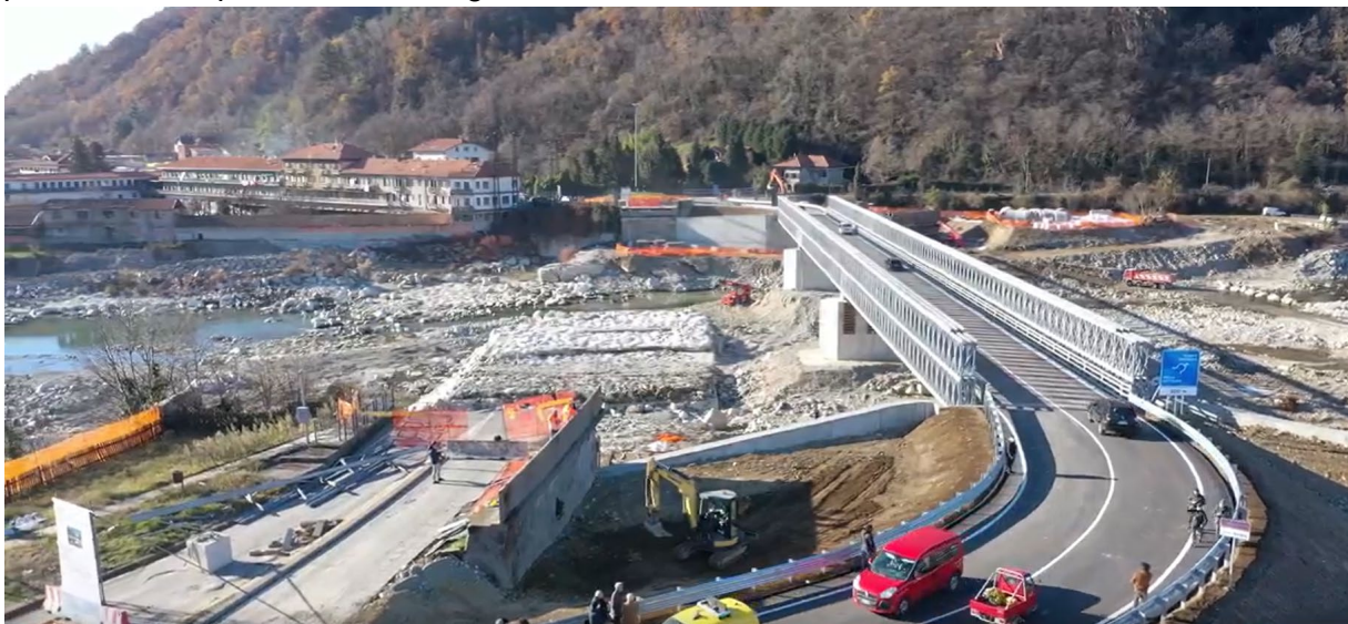
Ponte provvisorio realizzato
